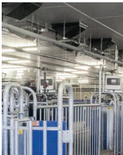
Rippenheizung als Raumheizung – ideal einsetzbar in Kombination mit Deckenventilen
