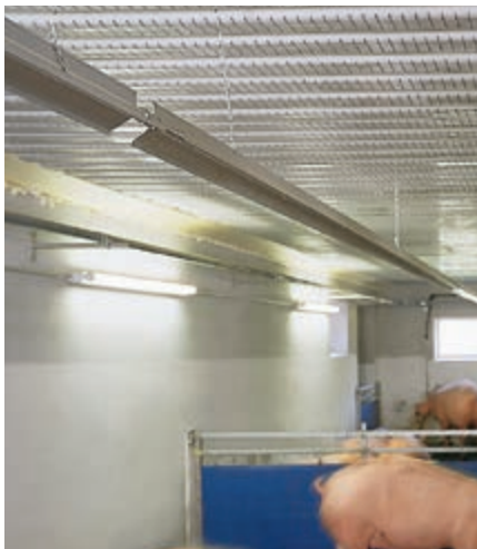
Deltarohr – ideal für Montage unter der DiffAir-Decke
